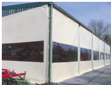
Séparation de hall industriel
