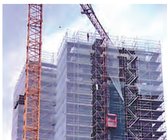
Pour échafaudage (gravats-sables-protection pluie,..)
