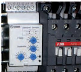
Ce dispositif à affichage de l'intensité arrête le treuil en cas de surcharge sans rupture de la chaîne cinématique.
