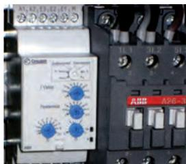
Ce dispositif à affichage de l'intensité arrête le treuil en cas de surcharge sans rupture de la chaîne cinématique.
